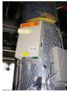
無線装置は配管または壁などに固定
